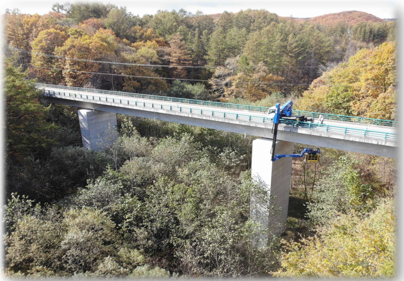
美盛橋 橋長 122.8m 竣工年 2003 年
