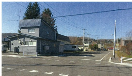
南2丁目通No. 9交差点 (整備後)
