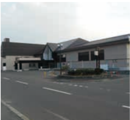
町民センター改修工事が完了しました。
