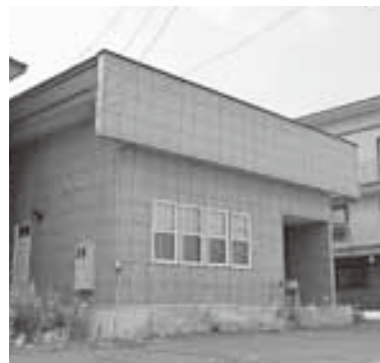
改装工事が進む公設民営塾
