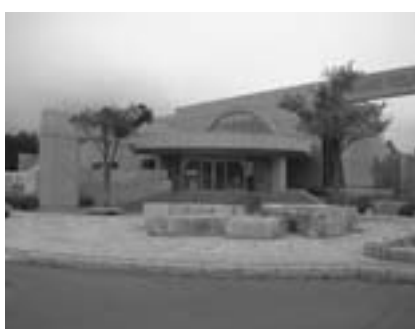
改修が予定される温水プール
