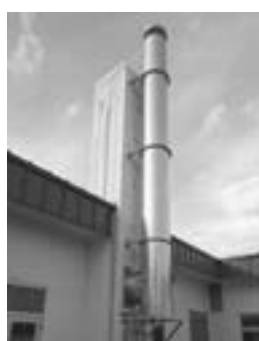
工事完了後の煙突
