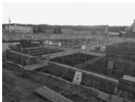
建設中の特別養護老人ホーム
