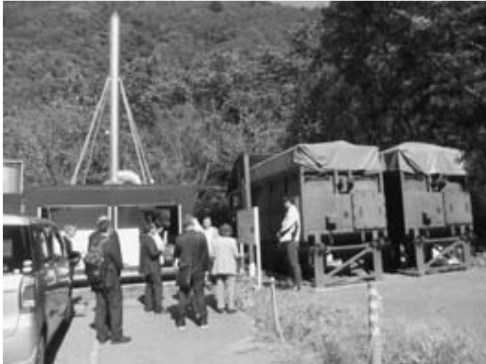
◀ 竜島温泉の木質バイオマスボイラー (写真左がチップボイラー、右が燃料コンテナ)
