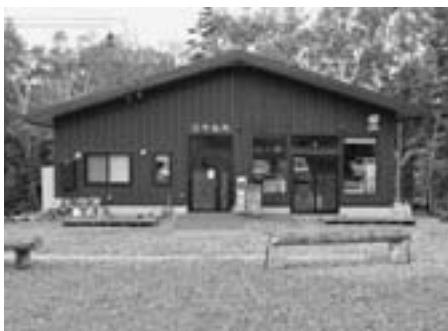
オンネトー休憩舎（令和3年撮影）
