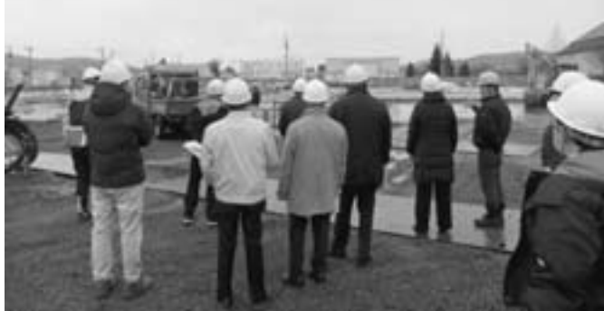
特養・デイサービスセンター新築工事を視察
