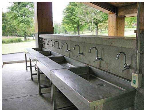
車いす利用者の利用を考慮した炊事場 写真右端に非常用呼出しボタンが見える 大山隠岐国立公園 蒜山野営場
