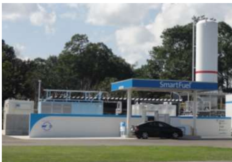
図 6.9 鹿追町水素ステーション
