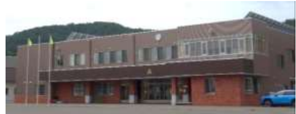
図 3.11 足寄中学校での太陽光設置事例
