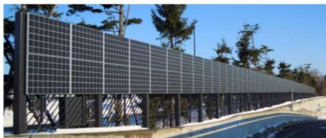
図 6.3 垂直設置型太陽光パネル（札幌ドーム；設備容量 90kW）
