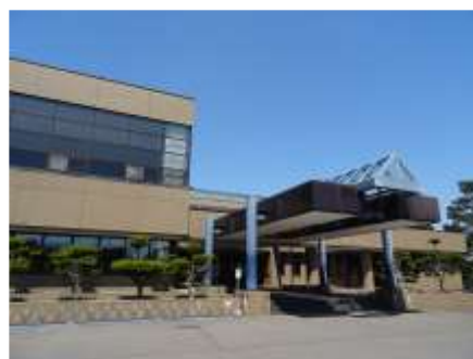
図 3.21 足寄町総合体育館
