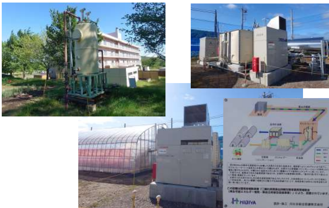
図 3.25 温泉付随ガスを活用したマイクロガスコージェネレーション設備とハウス
