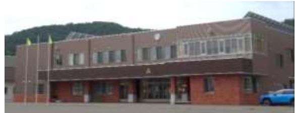
図 3.11 足寄中学校での太陽光設置事例
