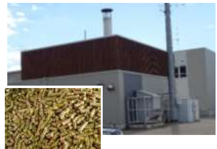
図 3.18 役場木質ペレットボイラー
