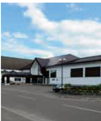
改修が進む町民センター
