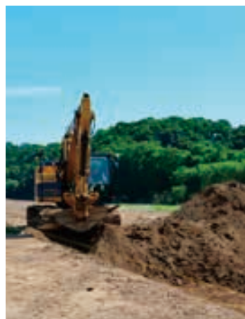
掘削による河道拡幅(利別川)
