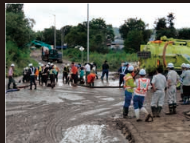
浸水した住宅街ではボランティアなどの協力の下、泥水の掻き出しや家財道具の洗浄作業に追われた
