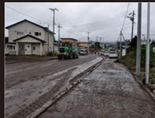
多量の水分を含んだ泥は重いため、重機を使っての大掛かりな作業に
