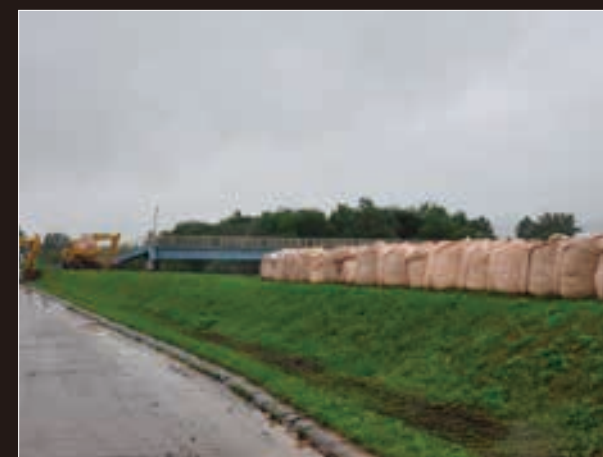
台風11号の上陸に備え、利別川・足寄川の両河川に土のうを積む作業が急ピッチで進められた
