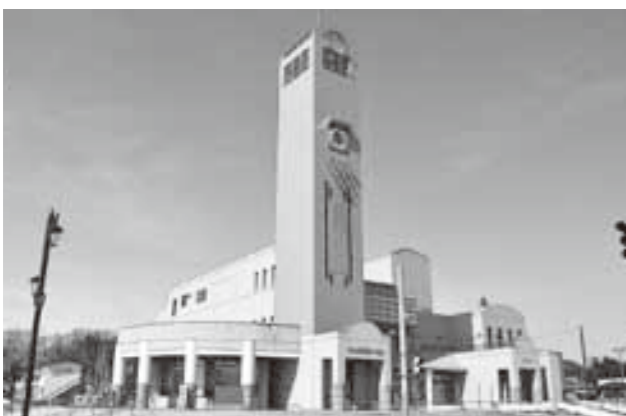
改修を待つ「あしよろ銀河ホール21」
