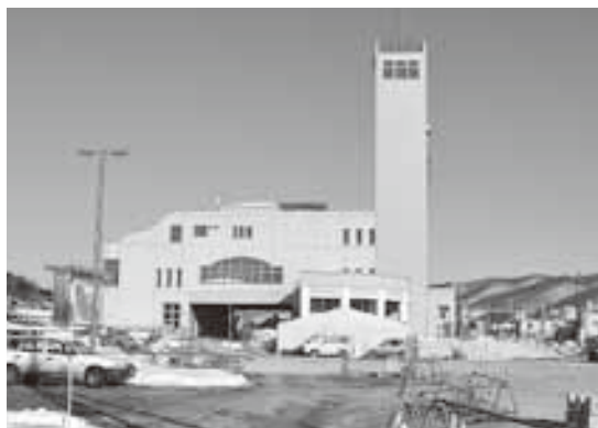
外構工事中のあしよろ銀河ホール21
