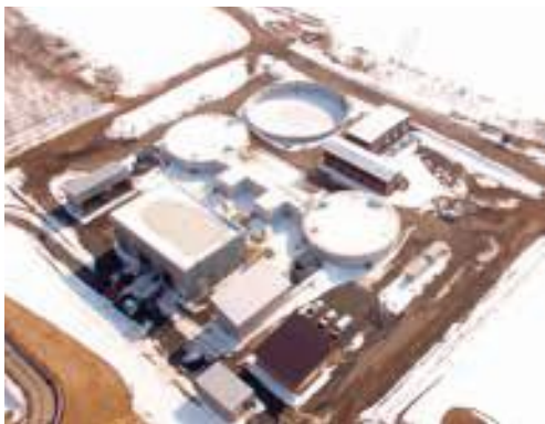
家畜排せつ物を廃棄物から資源へ変換するバイオガスプラント
