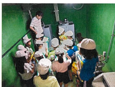
常盤浄水場見学
