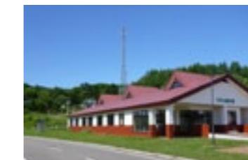
地下に真冬の冷気を閉じ込め、夏場まで農産物を保冷する実験施設。保冷に必要なのは換気扇を動かすわずかな電力のみです。
