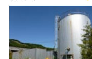
家畜ふん尿を微生物に分解させ、メタンガスを製造。発酵済の液体は肥料として畑に戻し、循環型農業を実践しています。
