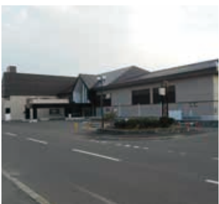
町民センター改修工事が完了しました。
