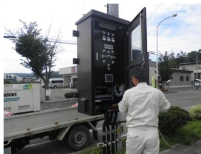
写真：北海道胆振東部地震発生時のマンホールポンプ復旧作業の様子
